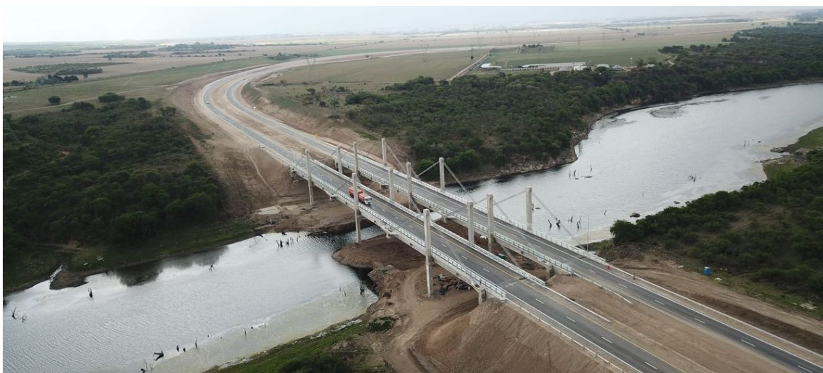
RN 36, Variante Perilago, Autopista Córdoba-Río Cuarto, Córdoba.
