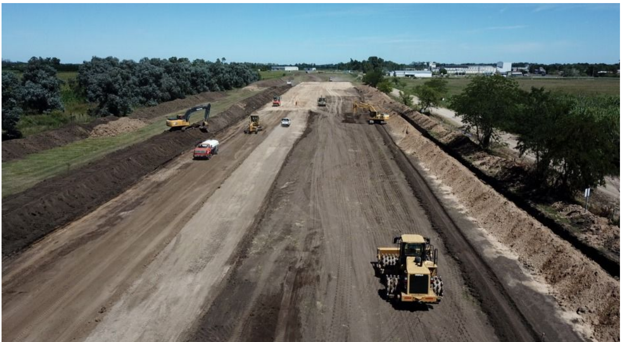
RN 3, Variante Cañuelas, Autopista Cañuelas-Azul, Buenos Aires.
