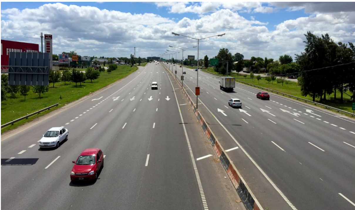
RN A008, Ampliación de Circunvalación a Rosario, Buenos Aires.
