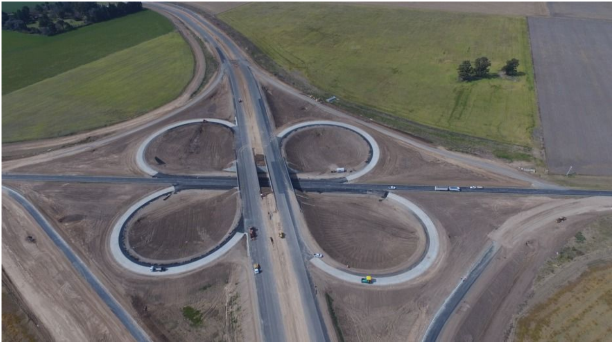
RN 8, Circunvalación Pergamino, Autopista Pilar-Pergamino, Buenos Aires.
