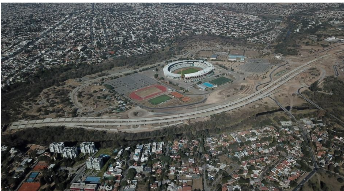
RN A019, Circunvalación Córdoba, Córdoba
