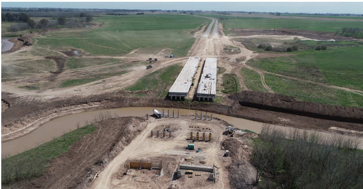
RN 8, Variante San Antonio de Areco, Autopista Pilar-Pergamino, Buenos Aires.
