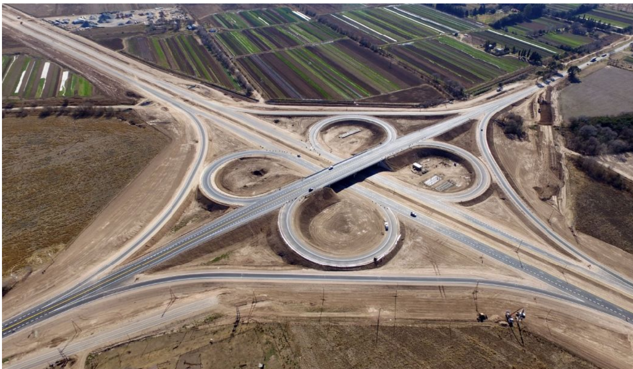
RN 36, Autovía en Variante a Almafuerde
